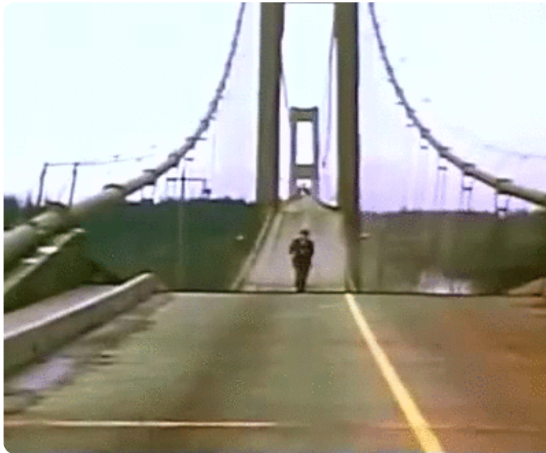
Deformate que me gusta (y me salva): el Tacoma Narrows Bridge es un ejemplo claro de que las deformaciones otorgan seguridad a las estructuras, permitiendo a la gente que las usa anticipar un eventual colapso.
