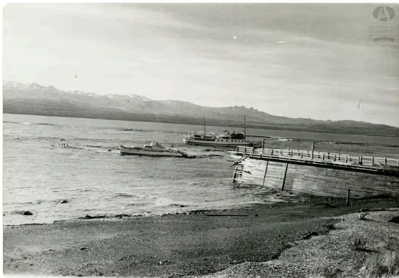
Costa del lago Nahuel Huapi, 22 de mayo de 1960, momento posterior al tsunami. El muelle ha sido destruido casi en su totalidad. Embarcaciones y restos del muelle flotando a la deriva. Puede observarse el alcance de la ola como la parte mojada (oscura) de la playa. Fuente: Archivo Visual Patagónico.
